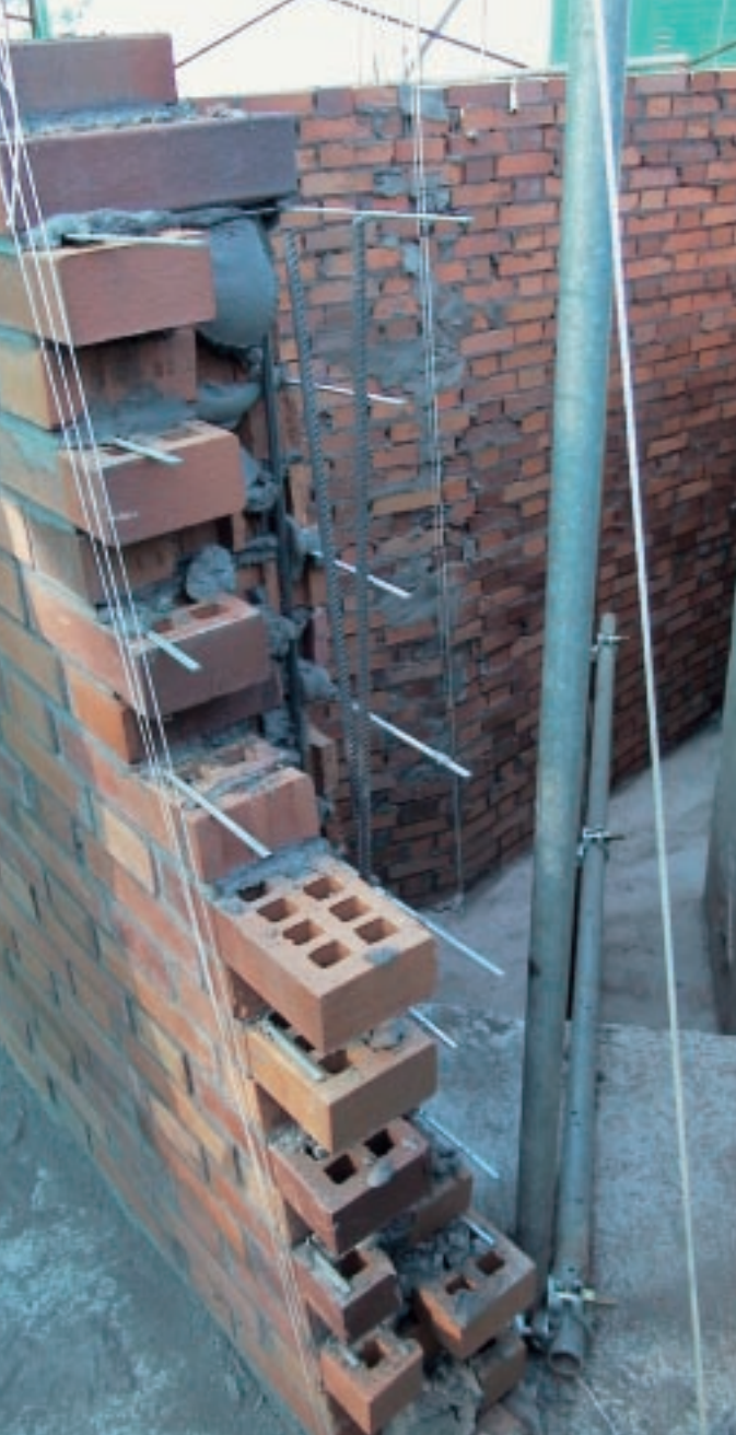
Dettaglio dell'apparecchiatura dei mattoni. In evidenza il posizionamento delle barre orizzontali.
