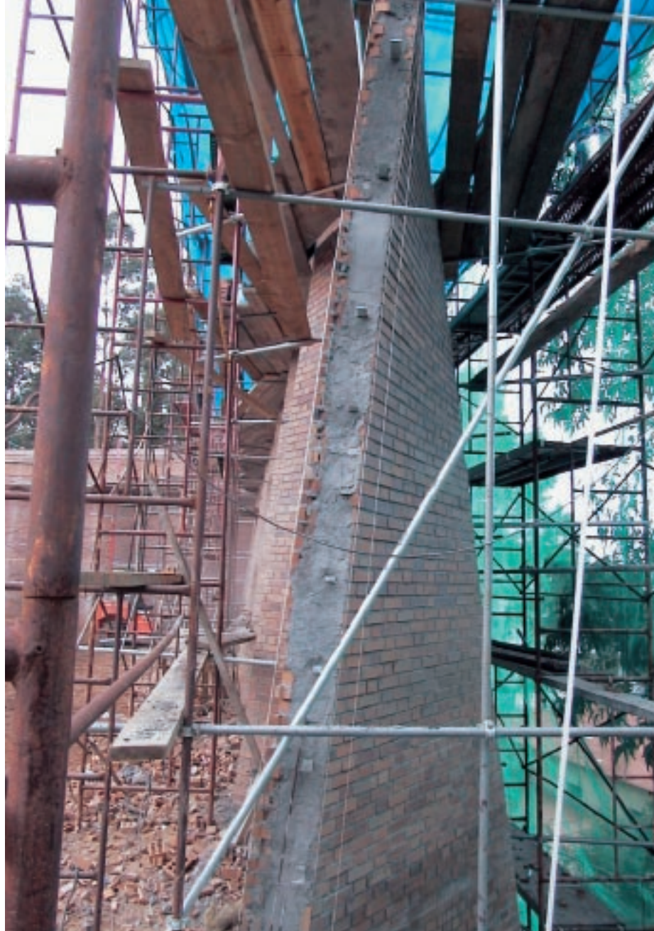
Vista di un giunto di dilatazione della muratura durante la fase di costruzione.
