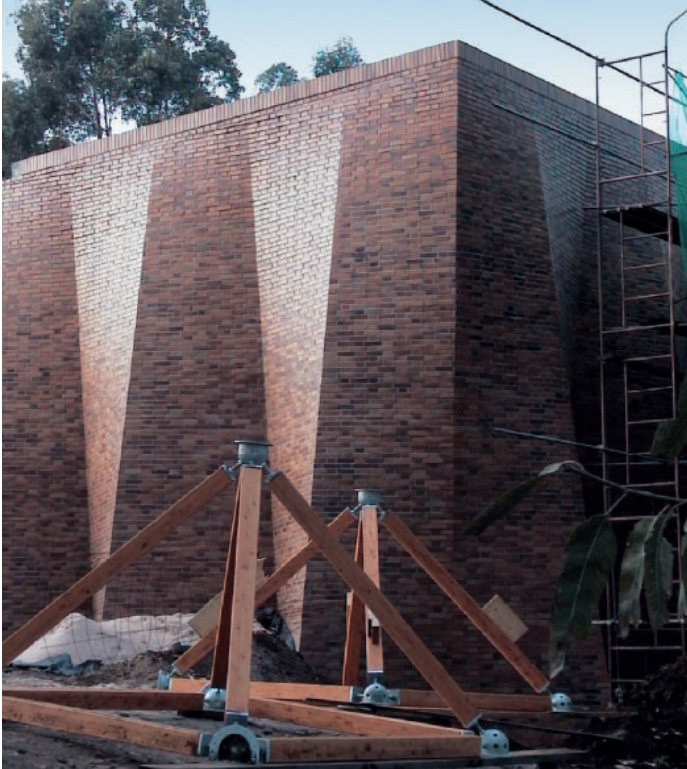
Vista dall'esterno di un angolo dell'edificio durante la costruzione: in primo piano, gli ottaedri della struttura di copertura in attesa di essere assemblati.
