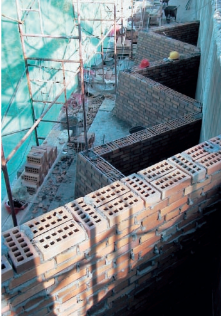
Veduta della muratura in fase di costruzione.
