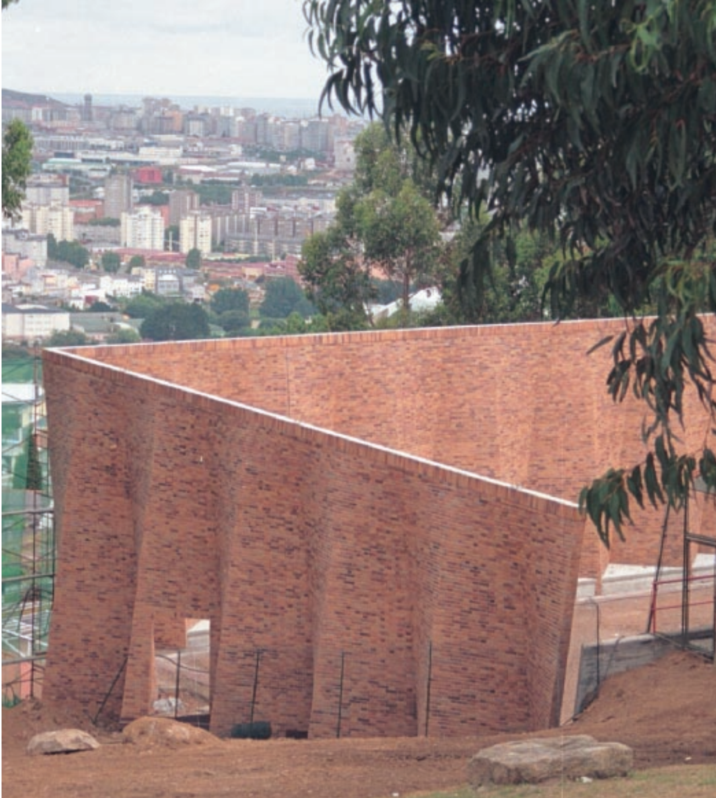
L'edificio prima del montaggio della copertura.
