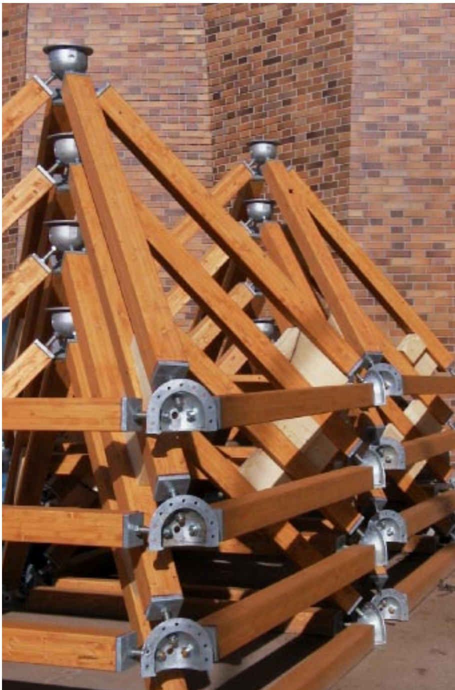
Ottaedri in legno lamellare utilizzati per la realizzazione della copertura reticolare.
