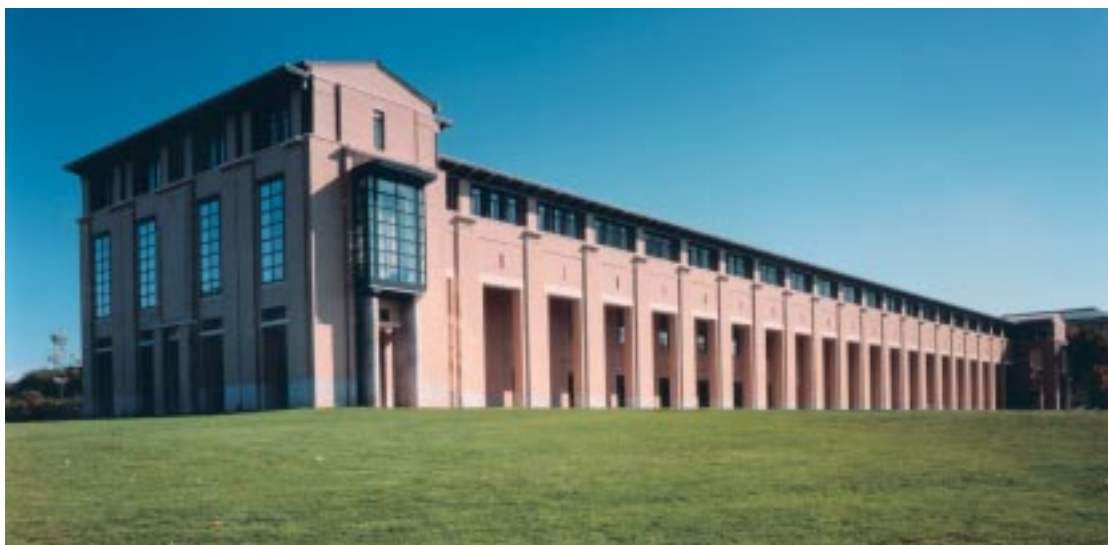
Vista del portico del Centro Comunitario da nord-ovest.
