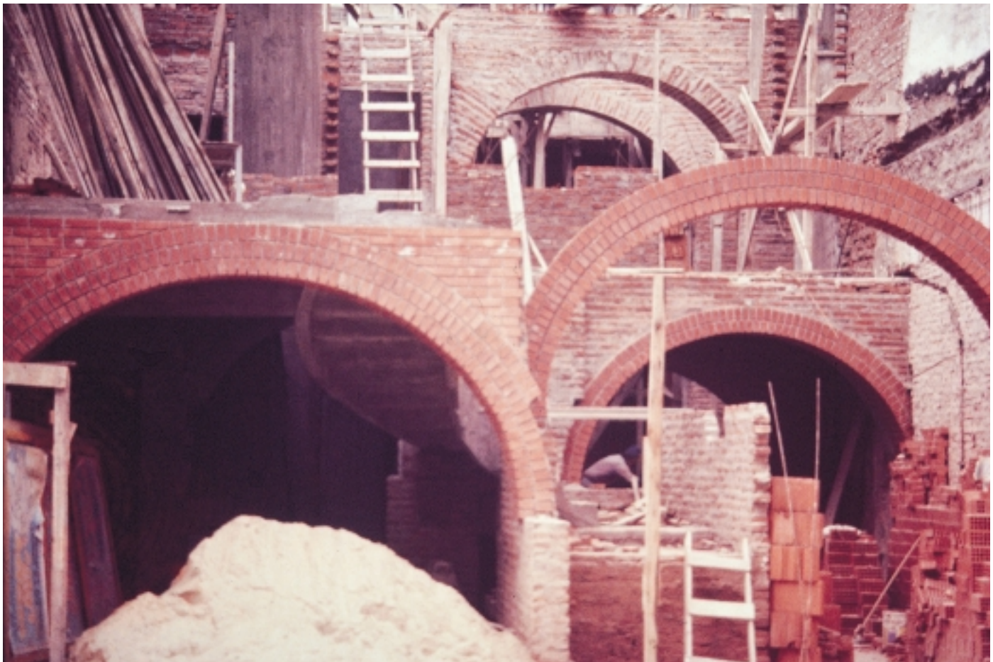
Vista dell'edificio in costruzione.
