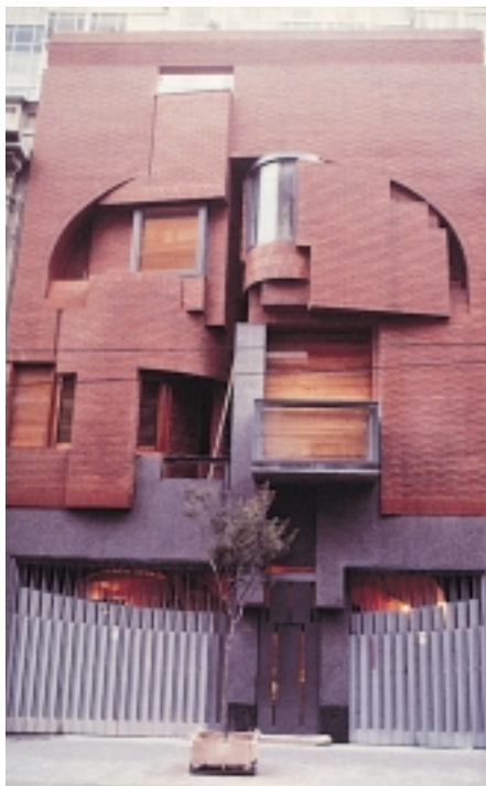
Vista della facciata.
