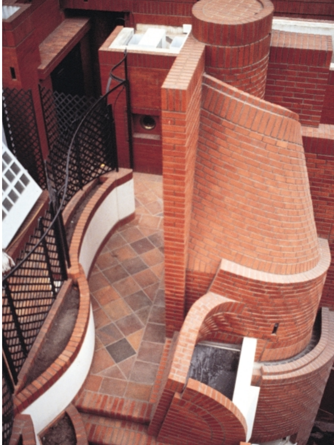
Scorcio della copertura.
