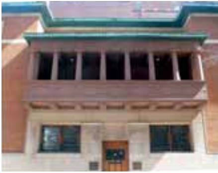
Facciata della Charnley House (foto: Irene Sagripanti).
