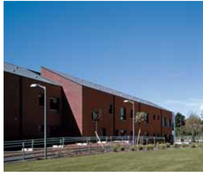
Veduta delle coperture inclinate rivestite in lastre di rame.
