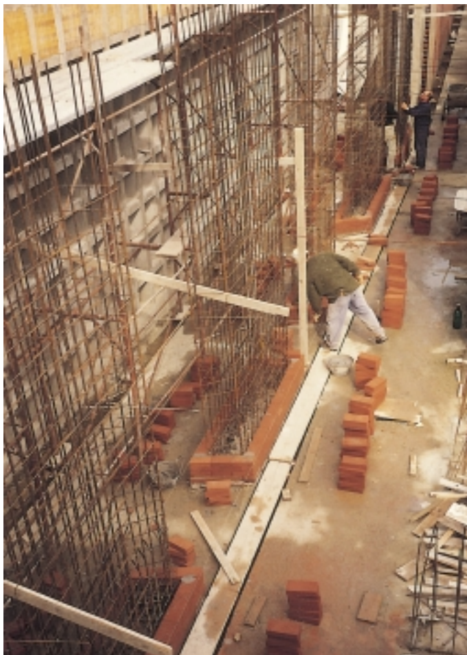
Particolare dei setti murari pluristrato in fase di realizzazione.
