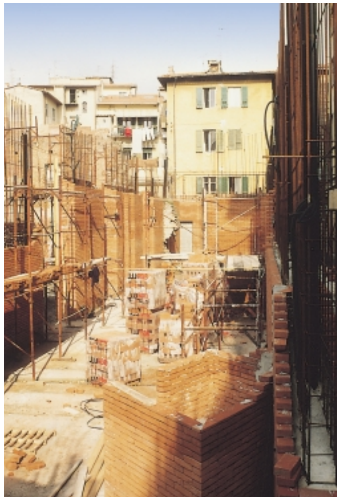
Particolare della esecuzione delle murature a sacco armate a San Michele in Borgo, a Pisa (1986-92).
