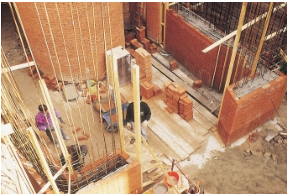
Particolare della struttura muraria pluristrato di un edificio di nuova costruzione.
