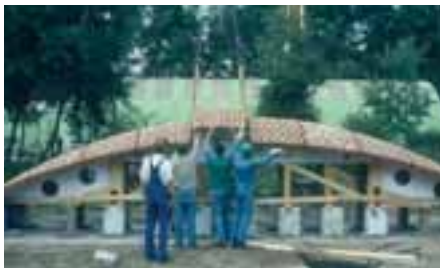
Fasi della prefabbricazione e dell'assemblaggio del primo prototipo.
