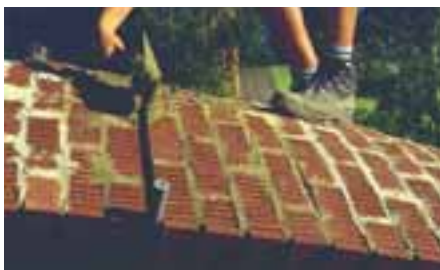
Tecnica di posa in verticale mediante cassaforma flessibile interfacciata con il modello computerizzato della superficie di muratura da realizzare. I cavi-guida modificano la loro posizione e aiutano il muratore nella posa precisa dei corsi di mattoni lungo curve sempre differenti.
