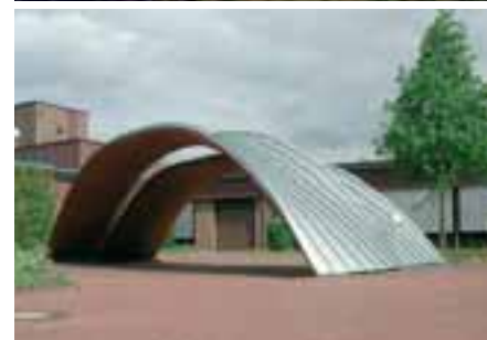
Fasi di finitura dell'estradosso, con intonaco e rivestimento in lamierino zincato.
