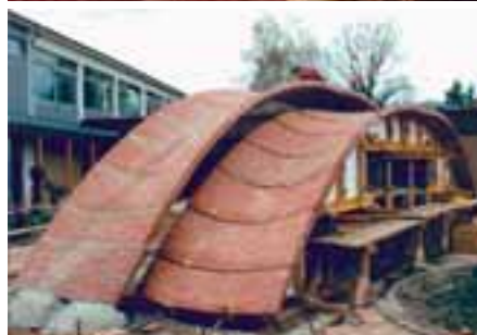
Fasi di prefabbricazione e assemblaggio del secondo prototipo a doppia curvatura negativa.
