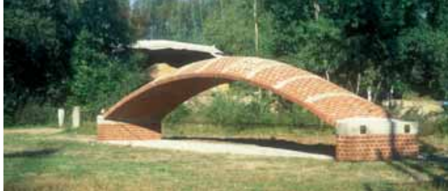
Differenti segmenti di muratura a doppia curvatura sono prefabbricati e assemblati in opera mediante giunti realizzati con estrema cura e con malta a presa rapida e senza ritiro.
