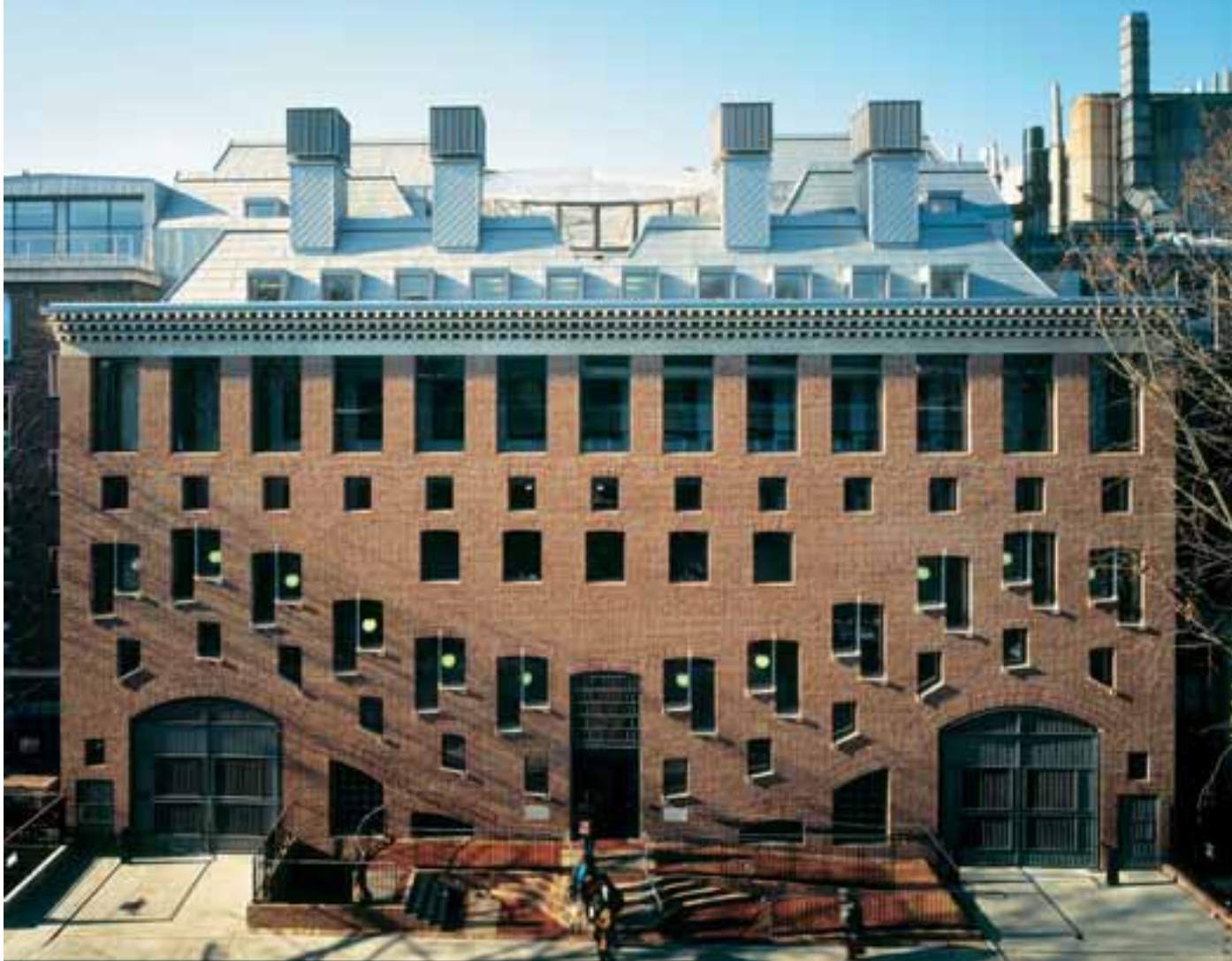
Veduta della facciata principale.
