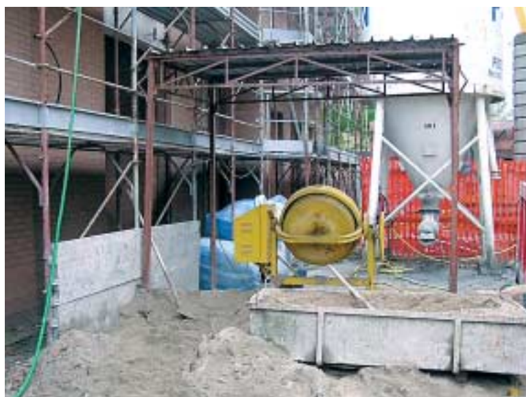
Fig. 20 - Predisposizione della tettoia. Altezza massima: tre metri sopra la postazione della betoniera.
