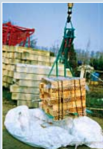
Fig. 8 - Esempio di sollevamento di laterizi con forca e sacchi di imbracco del carico (produzione Tecnobrevetti).
