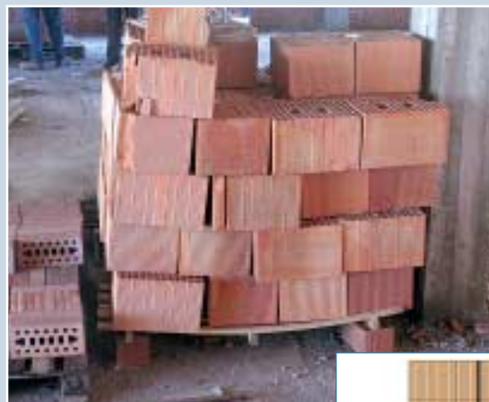
Fig. 9 - Evitare l'uso di listelli cedevoli o interporre morali in legno sotto ogni distanza per evitare deformazioni e instabilità.
