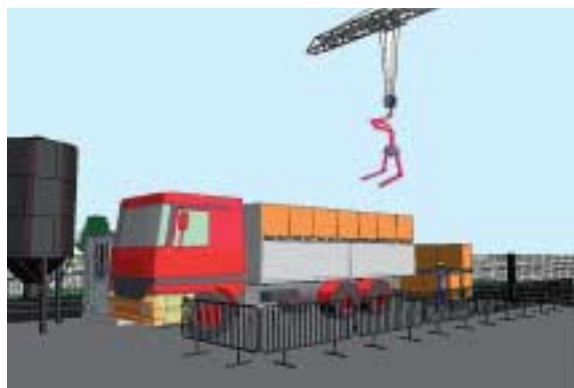
Fig. 5 - Scarico dei laterizi dal camion con l'uso di gru e forca da cantiere. È necessario delimitare l'area di lavoro con transenne metalliche o cavalletti e nastro bianco-rosso.
