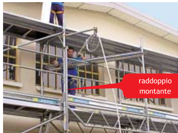
Fig. 13 - Raddoppio del montante del ponteggio in prossimità dell'elemento di sollevamento carichi.
