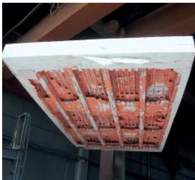
Fig. 6 - Solaio dopo l'esposizione al fuoco.
