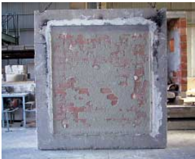
Fig. 1 - Parete intonacata: faccia esposta al fuoco dopo la prova.
