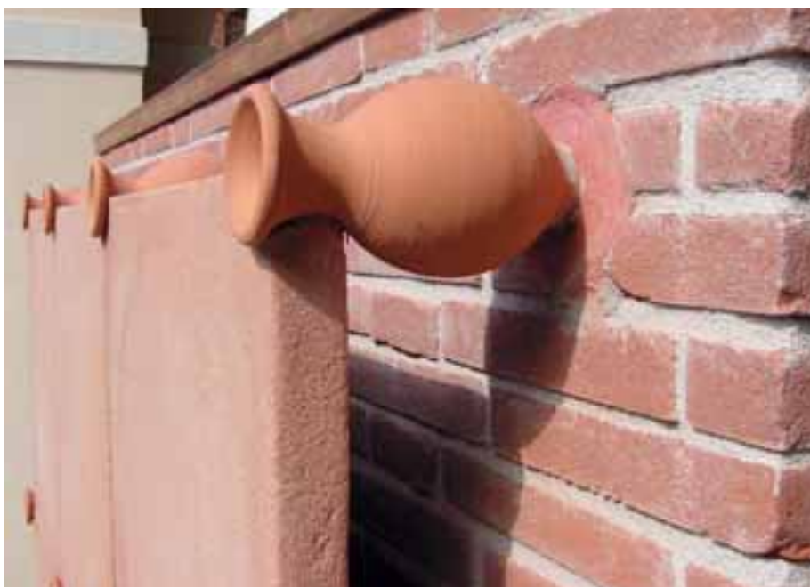
Dettaglio dell'appoggio sulle “anfore distanziatrici”.
